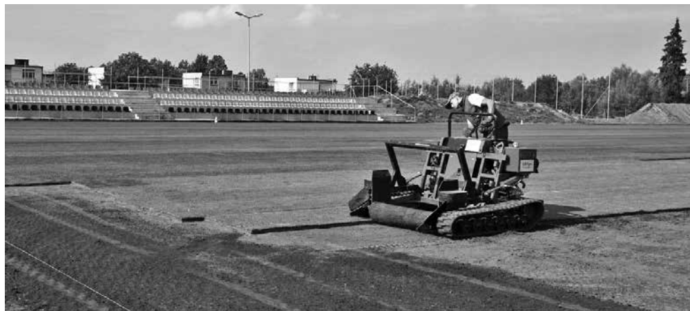
Fot. 7 Remont głównego boiska na stadionie przy ulicy Słupskiej
