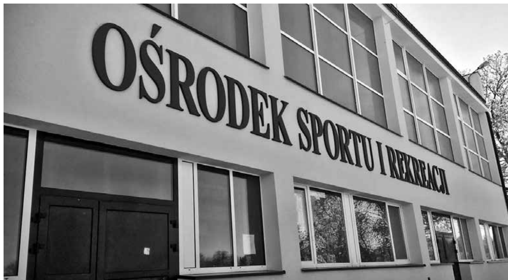
Fot. 5 Front hali Ośrodka Sportu i Rekreacji w Miastku
